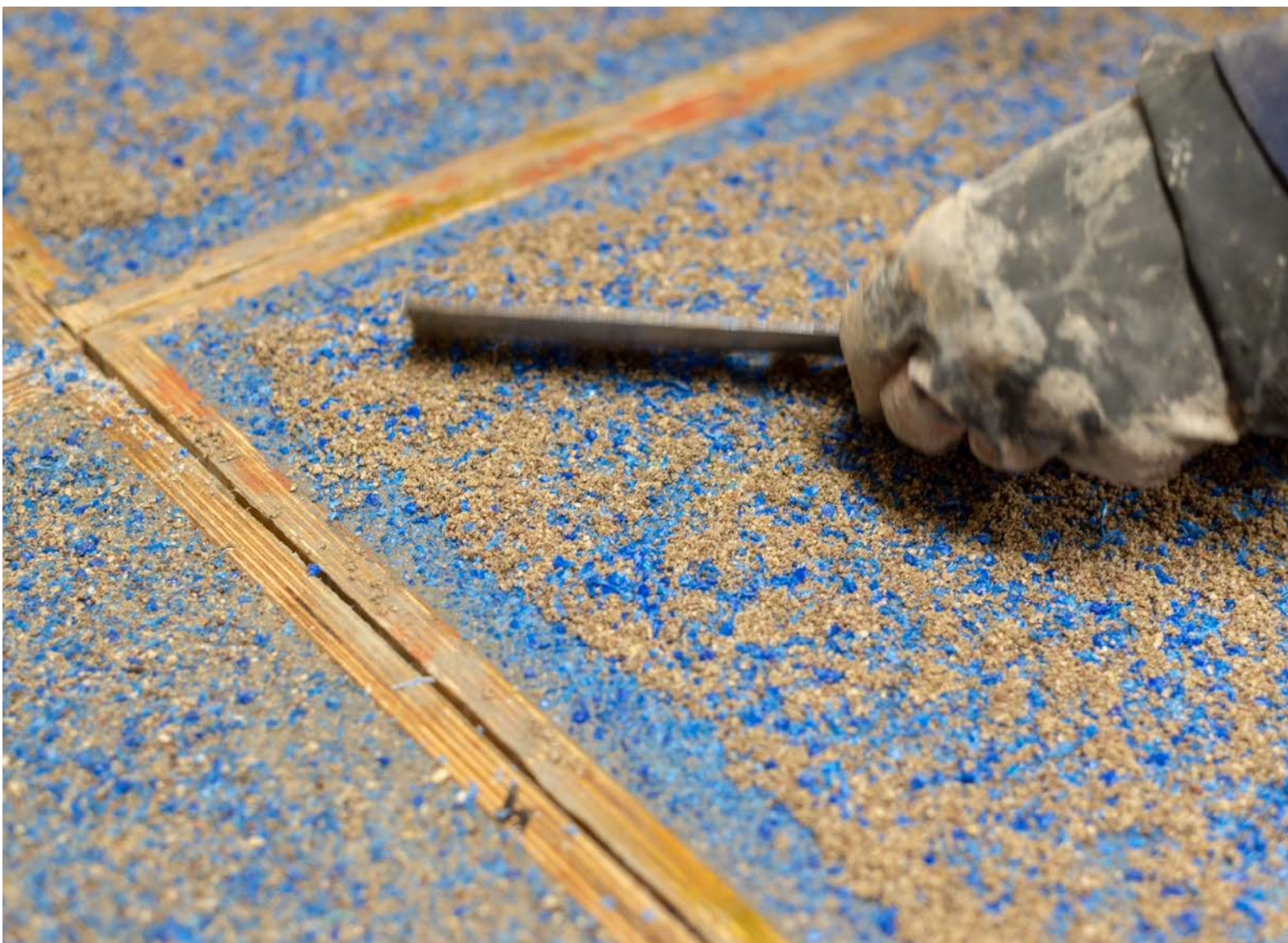
Κατασκευή Benthic Terrazzo
